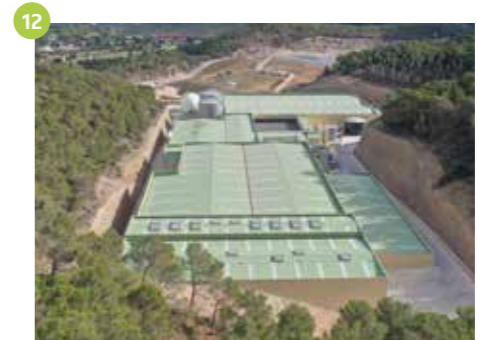
12 Kompostierungsanlage für Restabfall, Klärschlamm und Gärrest Ibiza (ES) 60.000 Mg/a Baujahr 2021
