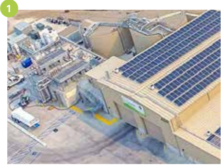
1 Trockenfermentation für Hausmüll und Bioabfall Santa Barbara (US) 67.000 Mg/a Baujahr 2020
